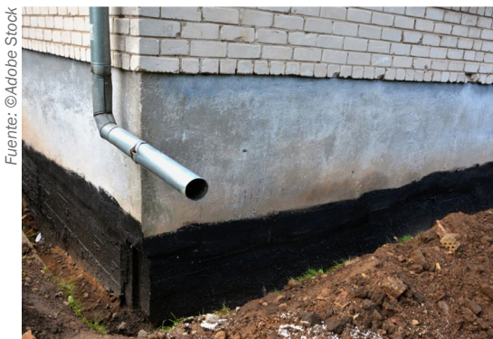
Imagen 2. Ejemplos de impermeabilización exterior de paredes de sótano en edificios existentes.
