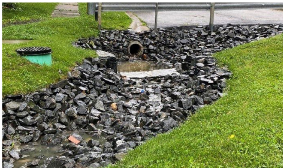
Imagen 36. Las escolleras pueden utilizarse para estabilizar las orillas de los arroyos y los desagües pluviales en los canales de desagüe.
