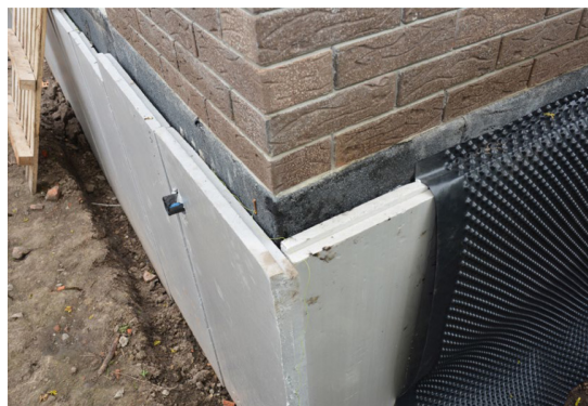
Imagen 2. Ejemplos de impermeabilización exterior de paredes de sótano en edificios existentes.
