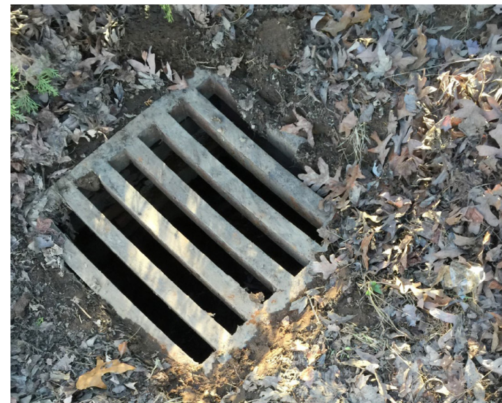
Imagen 16. Algunos patios pueden tener bocas de aguas pluviales conectadas a la red de alcantarillado pluvial del condado. Asegúrese de que el paso a la rejilla no esté bloqueado y de que el flujo de agua no quede obstaculizado. Retire las hojas de la zona para evitar que se obstruya el desagüe. Nunca vierta nada por las bocas de las aguas pluviales.
