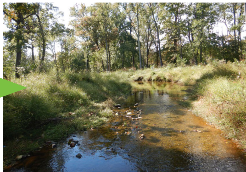
Imagen 31. La nivelación de las orillas del arroyo (izquierda) proporciona más espacio para que el agua se extienda durante los caudales de alto flujo, reduciendo la erosión. Al cabo de 3 años (derecha), la nueva vegetación cubre la zona nivelada.
