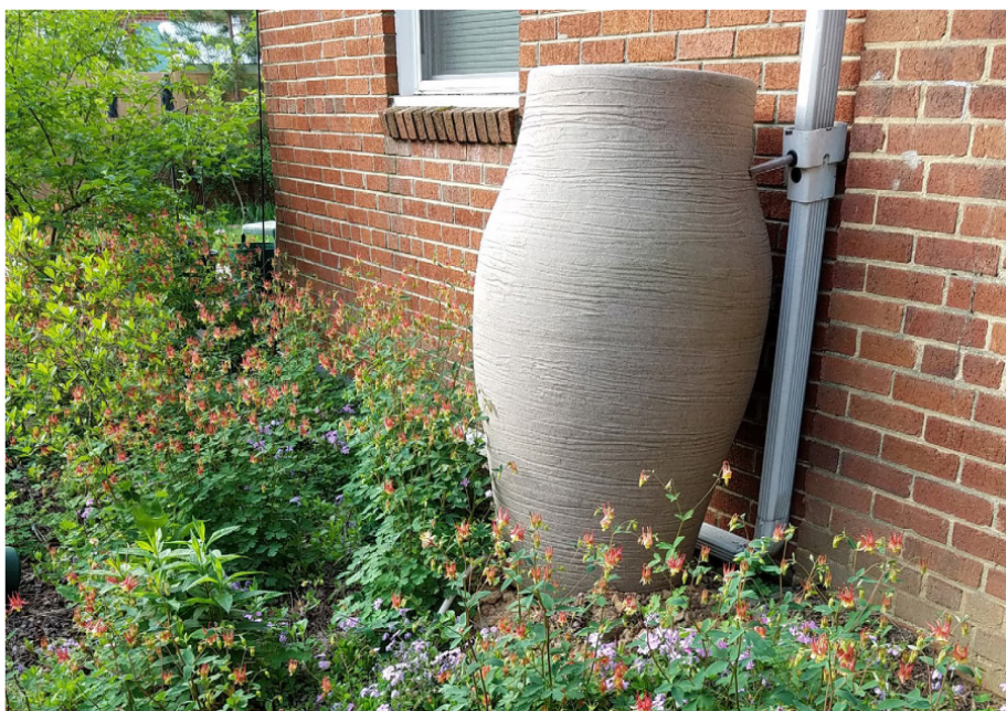
Imagen 19. Los barriles de lluvia recogen la escorrentía del tejado para regar flores, arbustos y árboles.
