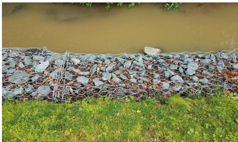
Imagen 37. Los gaviones consisten en jaulas de acero rellenas de rocas y se utilizan para ayudar a prevenir la erosión.
