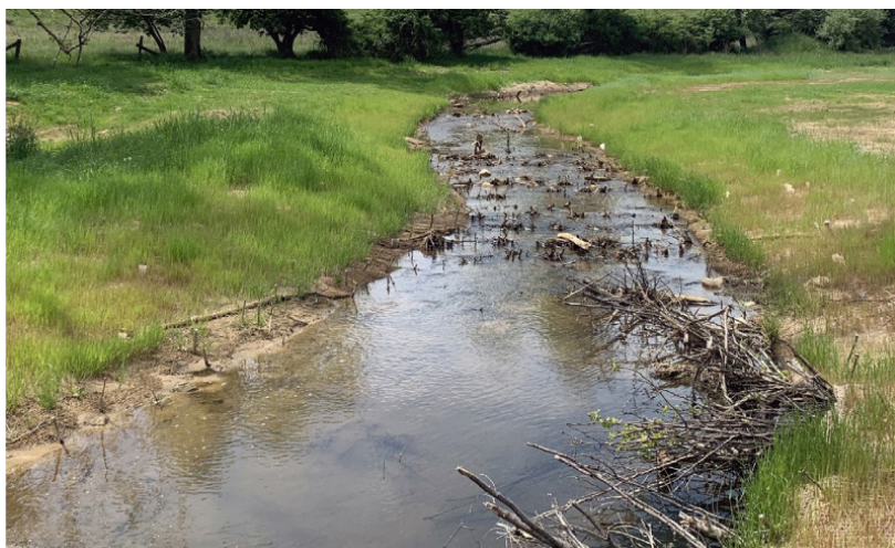
Imagen 32. La colocación de capas de ramas a lo largo de la orilla del arroyo proporciona estabilización a medida que la vegetación nueva se afianza y echa raíces.
