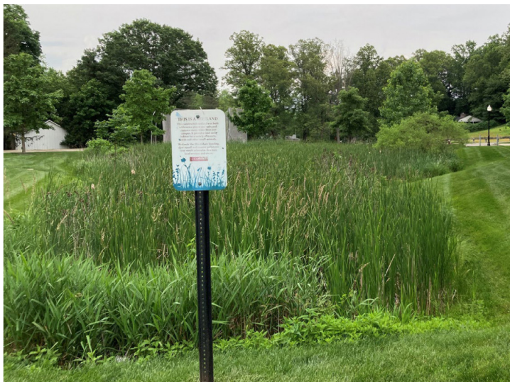
Imagen 27. El tamaño de los humedales artificiales varía. Este pequeño humedal construido captura la escorrentía en un entorno urbano.
