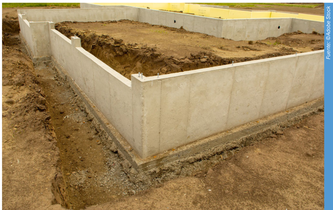
Imagen 1. Zapatas de hormigón y paredes de sótano en una casa en construcción.
