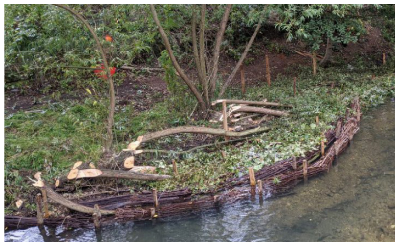
Imagen 33. Las fascinas son fardos de ramas fuertemente atadas que se utilizan para ayudar a prevenir la erosión.
