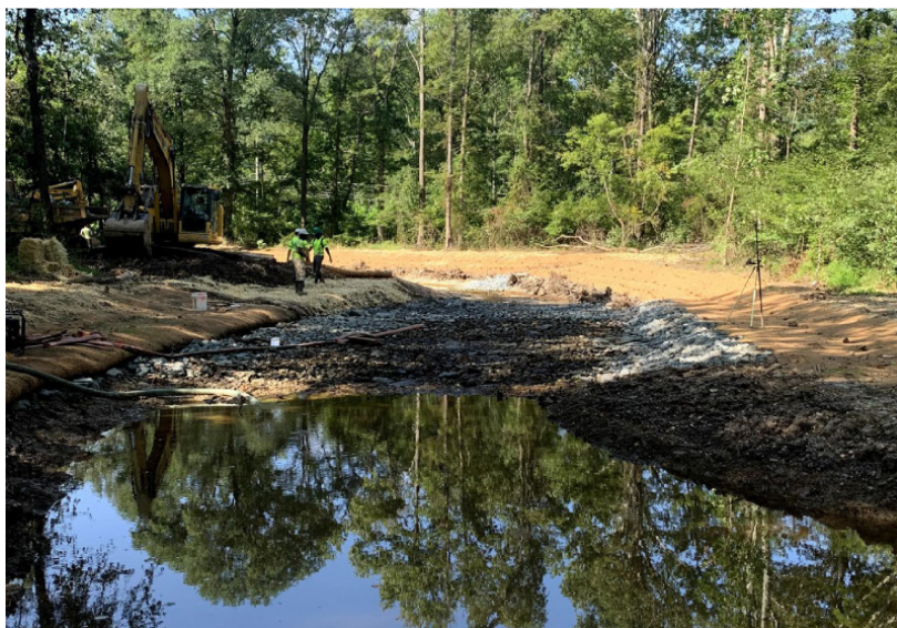
Imagen 31. La nivelación de las orillas del arroyo (izquierda) proporciona más espacio para que el agua se extienda durante los caudales de alto flujo, reduciendo la erosión. Al cabo de 3 años (derecha), la nueva vegetación cubre la zona nivelada.
